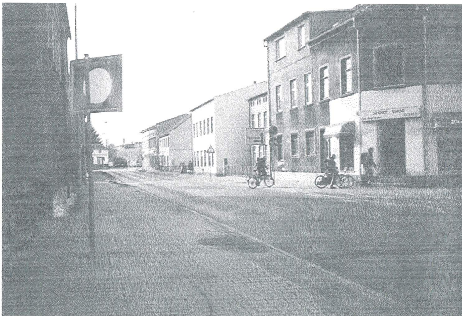
Foto 10: Standort Friedrichstraße im Kreuzungsbereich zur Schleusenstraße mit Blick Richtung Westen in die Friedrichstraße / Kreuzungsbereich Pasewalker Straße.
